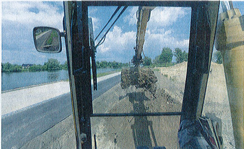
Noch genießt der Baggerfahrer den schönen Blick aufs Wasser. Doch auch auf diesem Teil der Promenade werden bald die ersten Häuser stehen.
